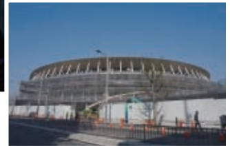
建設が進む国立競技場 (平成31年3月現在)
